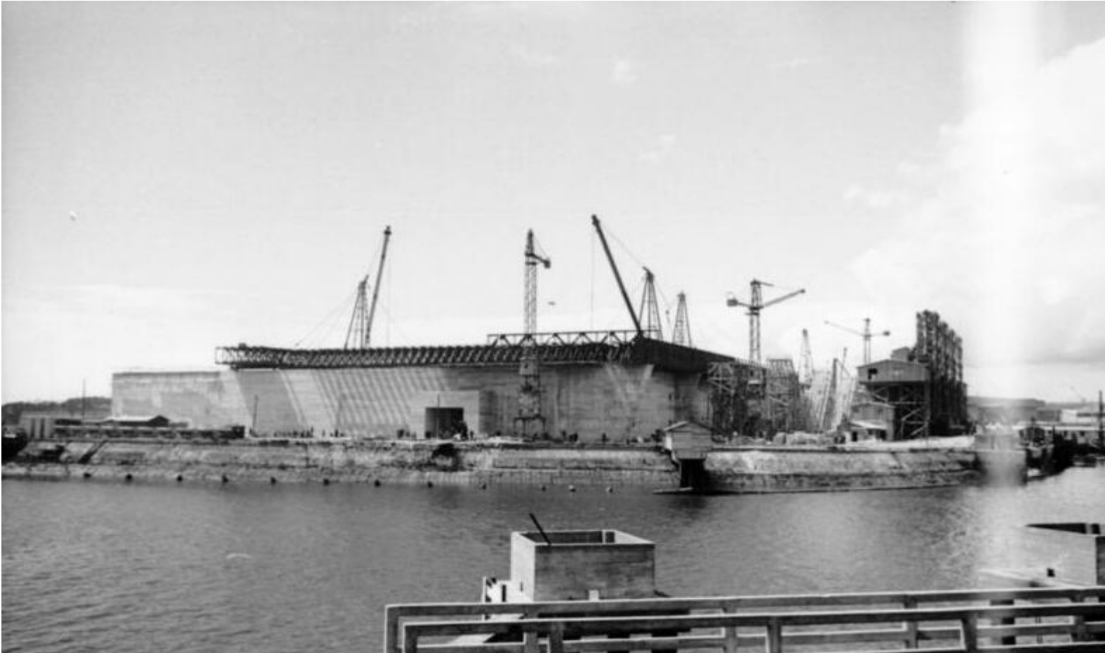
La base sous-marine de Lorient alors en construction en 1942. Source : Wikipédia
