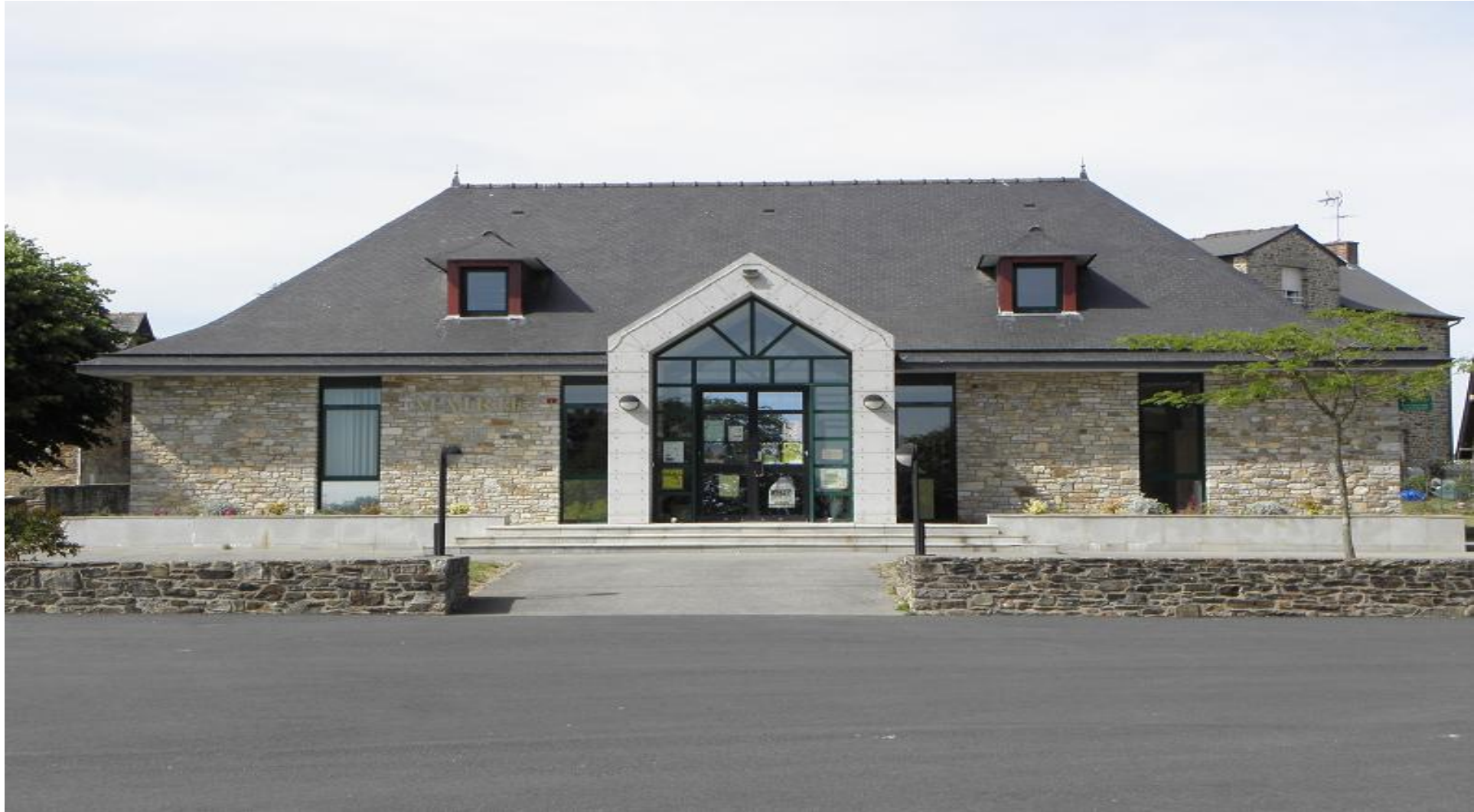
Mairie de Saint-Malo-de-Phily (35). Source : Wikipédia
