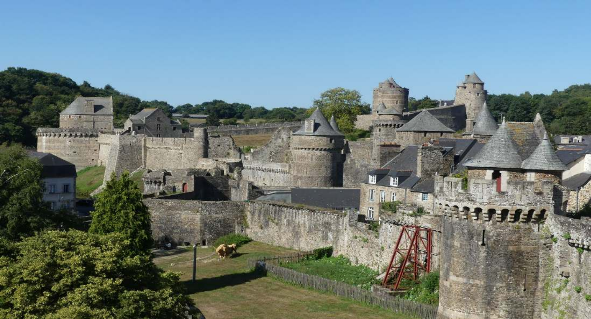
Le château de Fougères. Photo personnelle. Droits réservés
